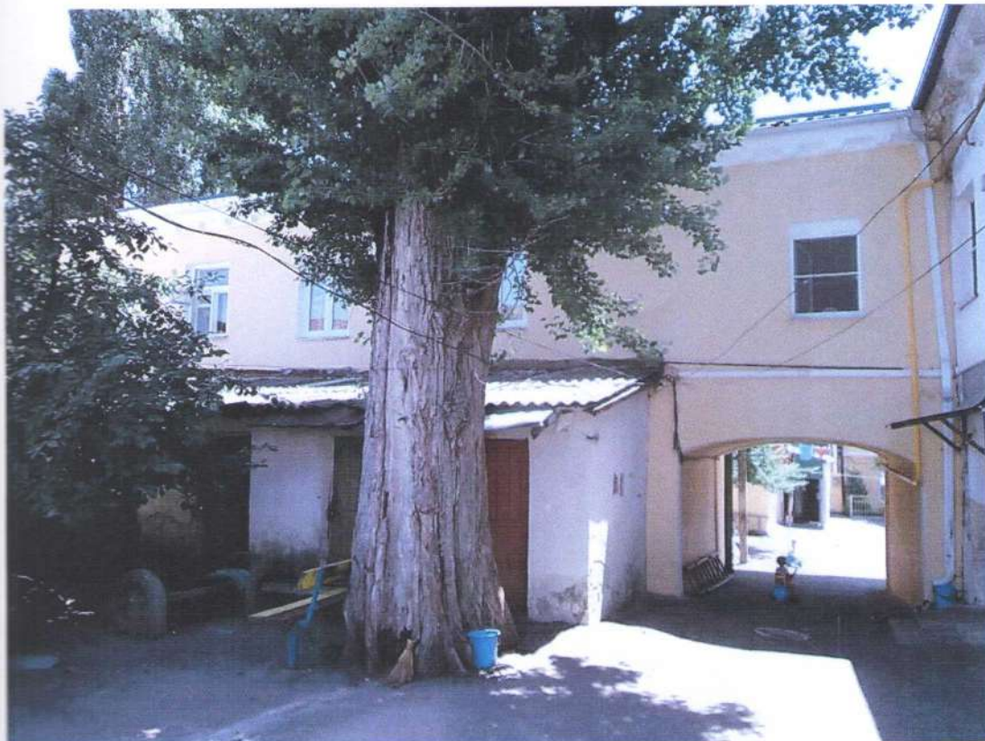
Фото 14. Объект культурного наследия регионального значения «Жилой дом», середина XIX века, Ставропольский край, г. Ставрополь, пр. К. Маркса, 67. Дворовый фасад.
