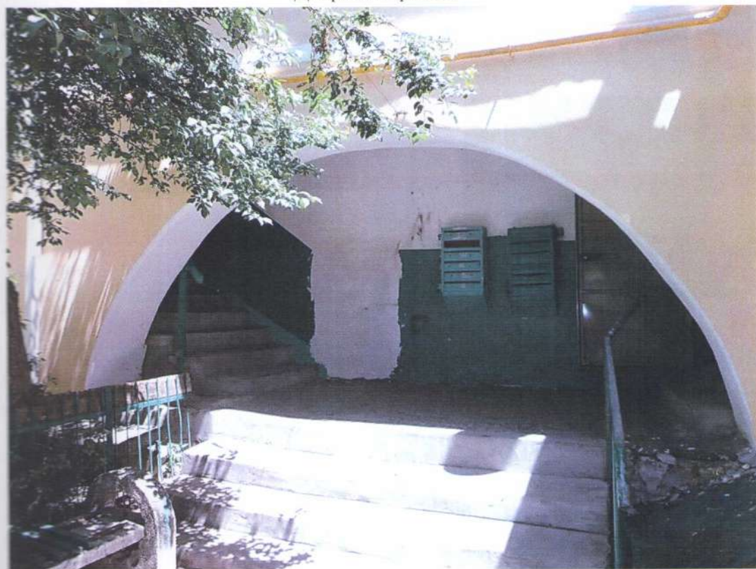
Фото 15. Объект культурного наследия регионального значения «Жилой дом», середина XIX века, Ставропольский край, г. Ставрополь, пр. К. Маркса, 67. Вход в северное крыло.
