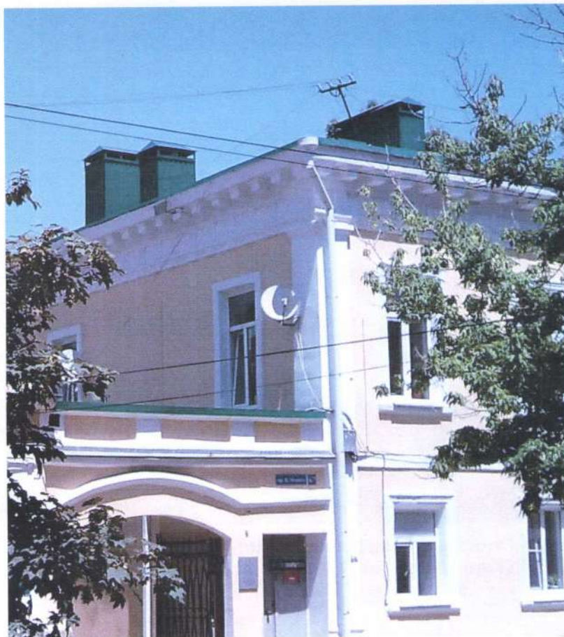
Фото 6. Объект культурного наследия регионального значения «Жилой дом», середина XIX века, Ставропольский край, г. Ставрополь, пр. К. Маркса, 67. Угловые пилястры на главном фасаде.
