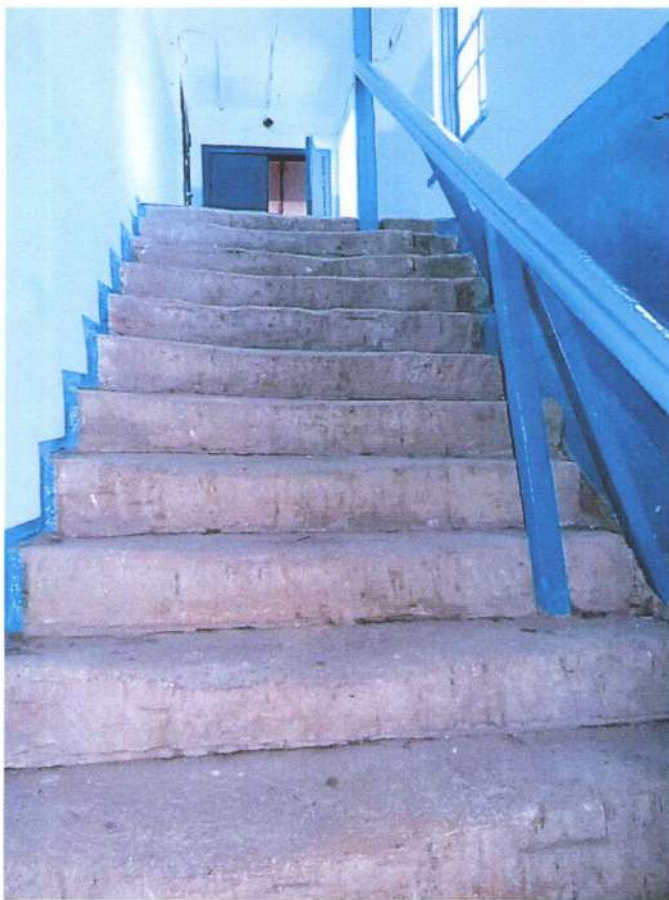
Фото 17-19. Объект культурного наследия регионального значения «Жилой дом», середина XIX века, Ставропольский край, г. Ставрополь, пр. К. Маркса, 67. Межэтажные лестницы в северном крыле.
