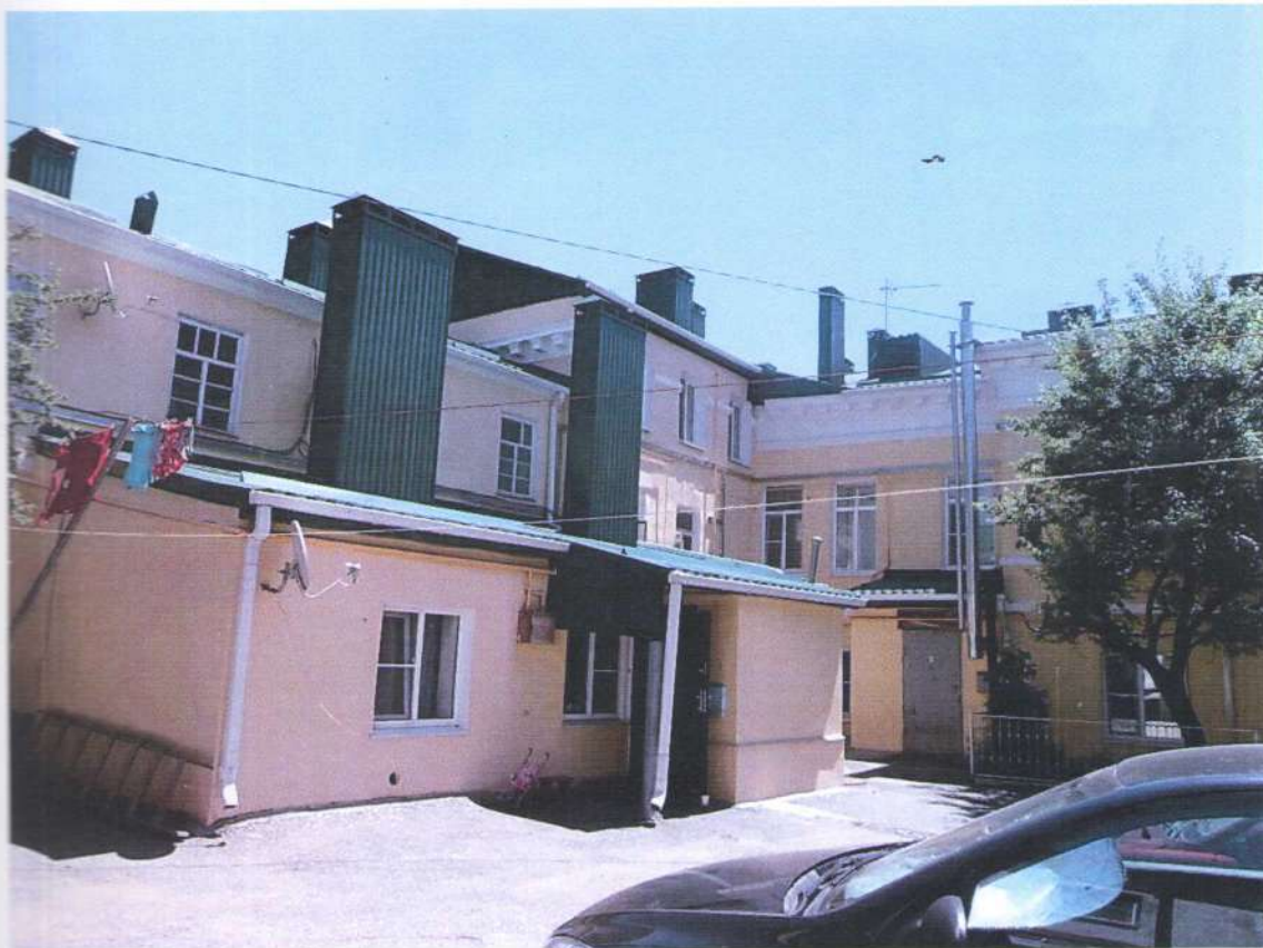
Фото 12. Объект культурного наследия регионального значения «Жилой дом», середина XIX века, Ставропольский край, г. Ставрополь, пр. К. Маркса, 67. Дворовый фасад.
