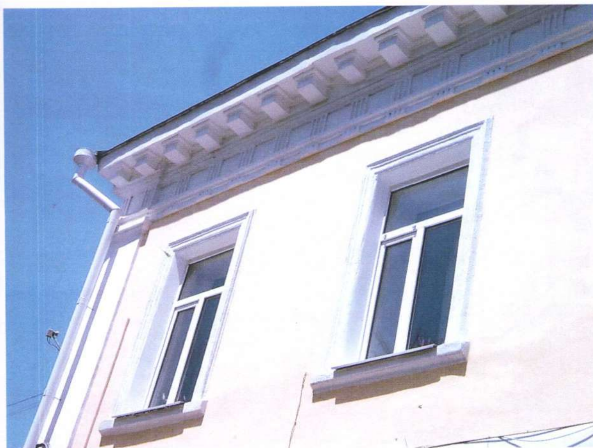
Фото 5. Объект культурного наследия регионального значения «Жилой дом», середина XIX века, Ставропольский край, г. Ставрополь, пр. К. Маркса, 67. Венчающий карниз с мутулами.
